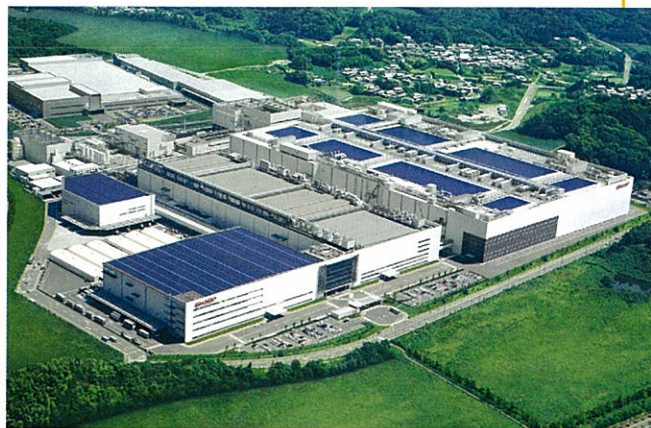
シャープ亀山工場 (資料提供：シャープ)
