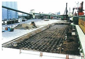
砕石ドレーン工法の施工状況
