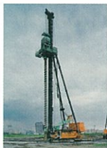
砕石ドレーン工法の施工状況
