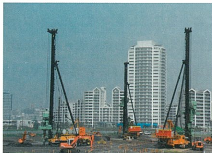
施工中の状況
