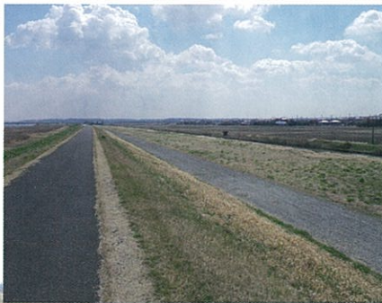
液状化対策を 施した部分
