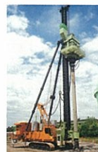
地中におけるケーシング先端部の状況
