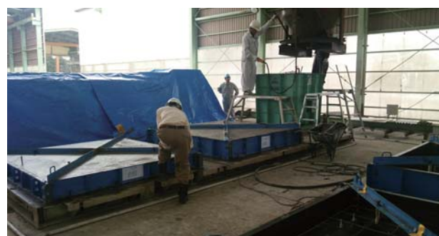
【試験体打設状況】
