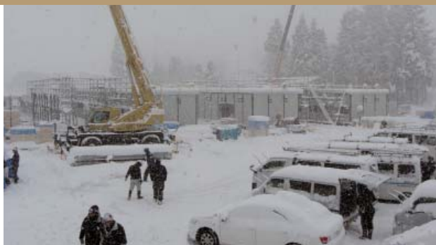
【写真3 建設工事の様子（白馬村）】
