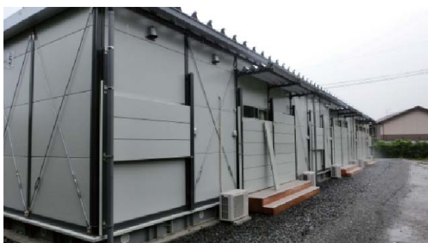
【写真5 パネル式耐風養生（屋久島町）】
