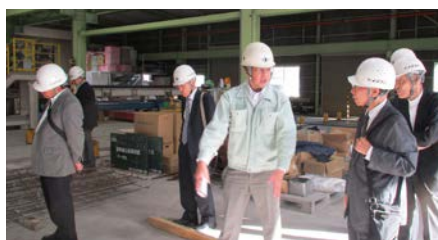
場内パトロール状況
