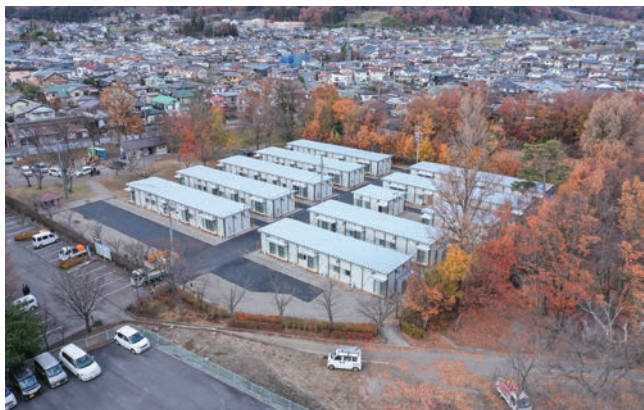
昭和の森公園応急仮設住宅団地(長野県)
