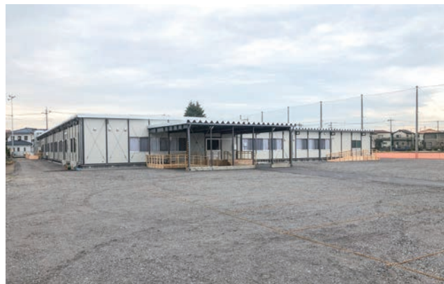
川越霞ヶ関北福祉仮設住宅(埼玉県)
