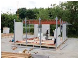
壁パネル落し込み
