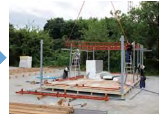
柱及び梁組立
