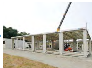
フレーム組立完了
