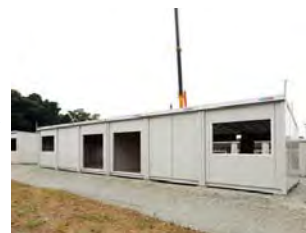
壁パネル組立完了
