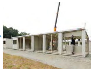
壁パネル組立
