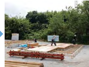
床パネル敷き込み
