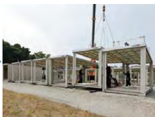
フレーム連結組立
