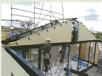
■工場プレ加工による現場施工の合理化
