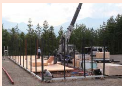
4. 柱取付・床パネル敷込み
