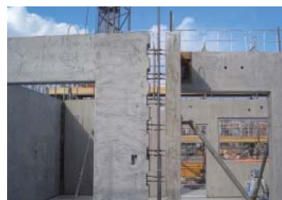
7. PC 壁板の接合部の例
