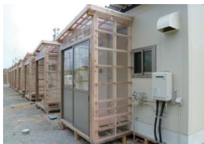
1. 風除室の設置
