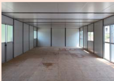
8. 天井パネル取付
