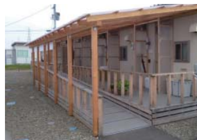
3. スロープの設置
