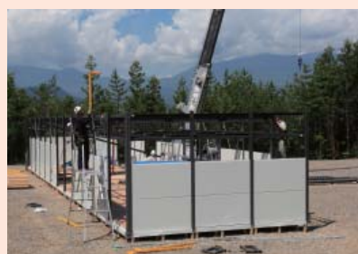
6. 小屋梁・モヤ材組み立て
