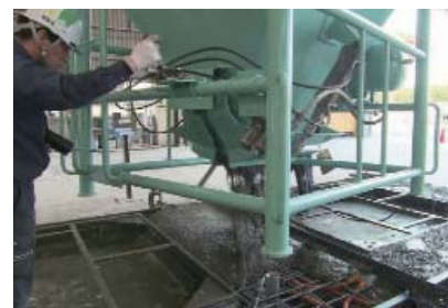
3. 開口付きPC壁板へのコンクリート打込み状況
