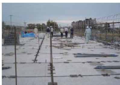
5. PC 床板の組立て状況
