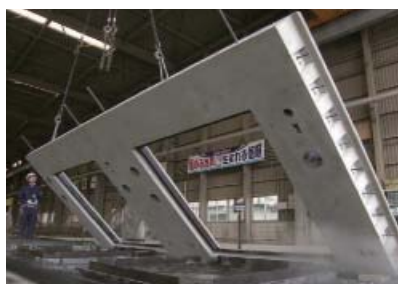
4. 開口付き PC 壁板の脱型状況
