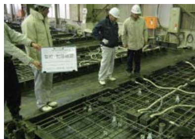
2. PC床板の型枠・配筋確認状況
