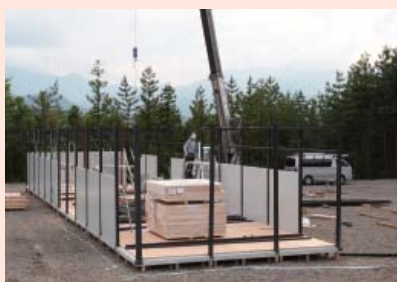
5. 壁パネル落とし込み
