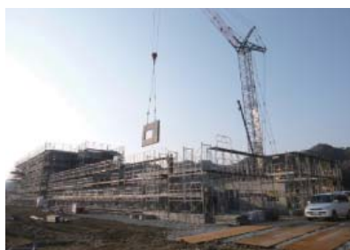
6. PC 壁板の吊上げ状況
