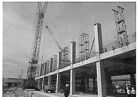
PS-PC工法の建設現場の視察
