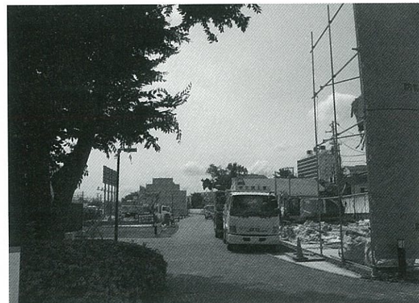
解体工事が進む展示場
