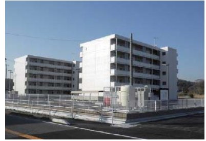
② 沼ノ内団地(手前2号棟、左奥1号棟)
