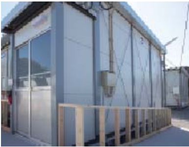
柱カバーの取付け
