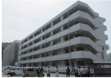
⑤ 豊間団地(手前6号棟、左奥5号棟)
