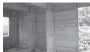
壁・柱部材の状況
