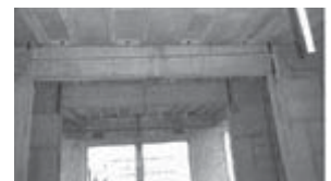
床部材の状況
