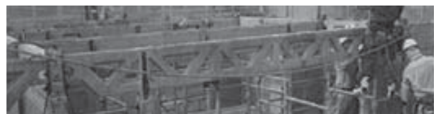
梁部材の状況
