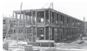
昭和31年躯体工事状況
