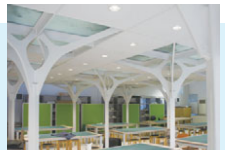
徳田先生がディレクターとして、旧ボイラー棟を改修した九州工業大学の新製図講義棟。
