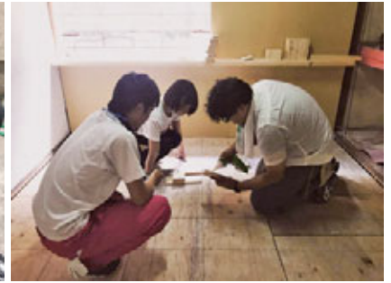
DIYワークショップにて 実施した床の張り替え。
