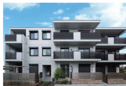
壁式プレキャスト鉄筋コンクリート造の 自宅併用賃貸マンション
