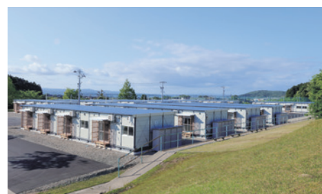
令和6年能登半島地震により建築された 仮設団地「垣吉町第1団地」
