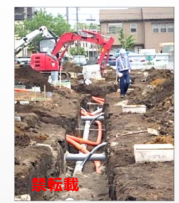
● 道路内配管事例
