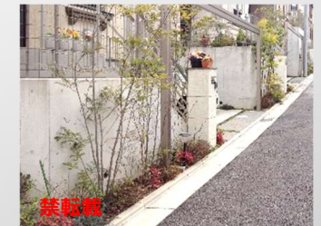
●コンクリート リブ型枠
