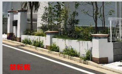
●コンクリート擁壁に吹き付け塗装 +アクセント花台+擁壁前面植栽
