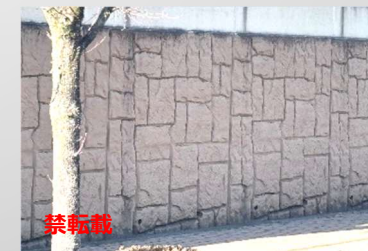
●コンクリート 石張り風型枠+塗装
