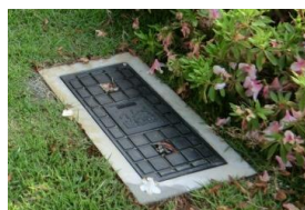
■ マンホール型 トイレ排水 ・ライフライン復旧 までトイレ排水を 確保。
