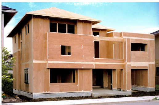
図 2.19 構造躯体 (ミサワホームの例)
