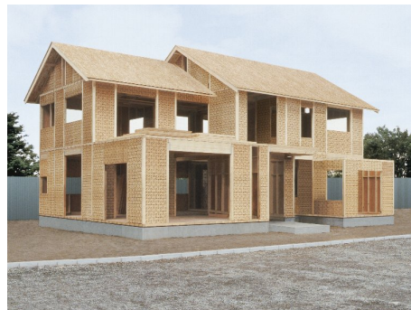
図 2.20 構造躯体 (ヤマダホームズの例)
