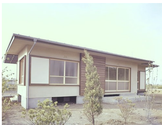
図 2.1 木質パネル接着工法試作住宅第 1 号 (1961) 1)
