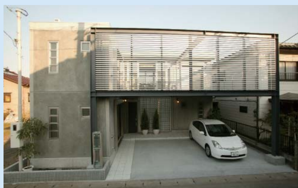
トヨタ T & S 建設
