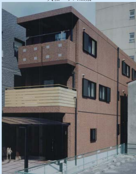
トヨタT & S建設
