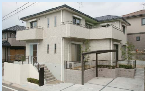
トヨタ T & S 建設
